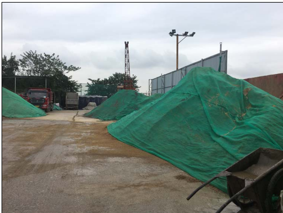
图 5.2- 堆场处已设置实体挡墙、金属防尘挡板和抑尘网
