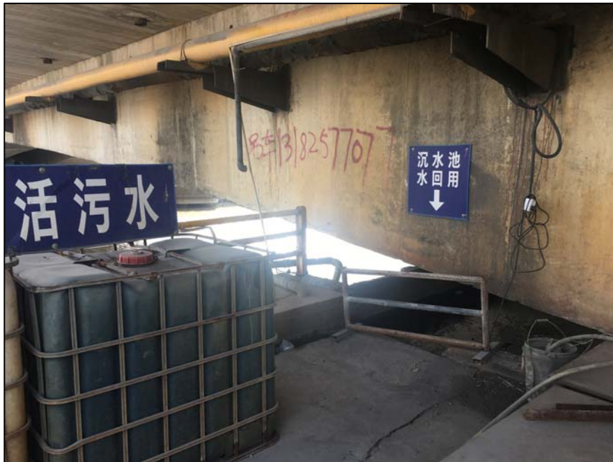
图 5.1-2 码头处沉淀池
