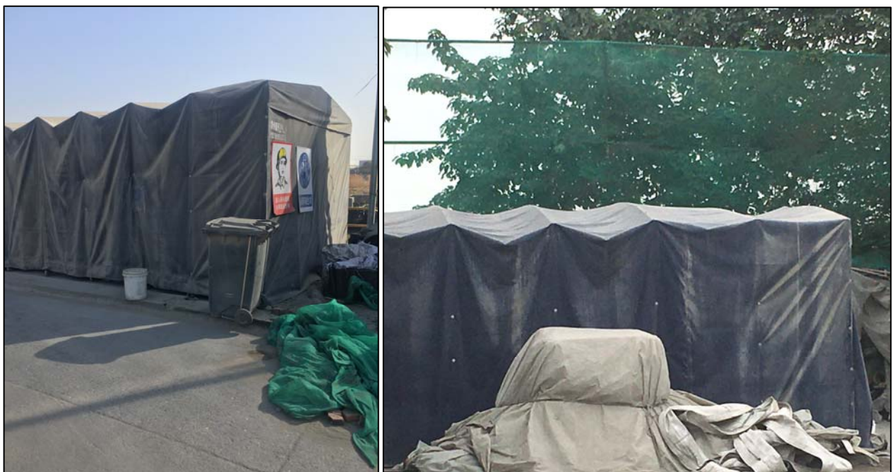
图 5.2-1 码头处 2 间密闭的水泥库房（堆放袋装水泥）
