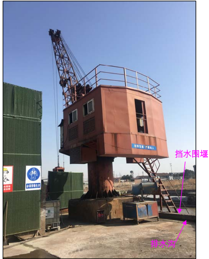
图 5.1-1 码头处挡水围堰和排水沟
