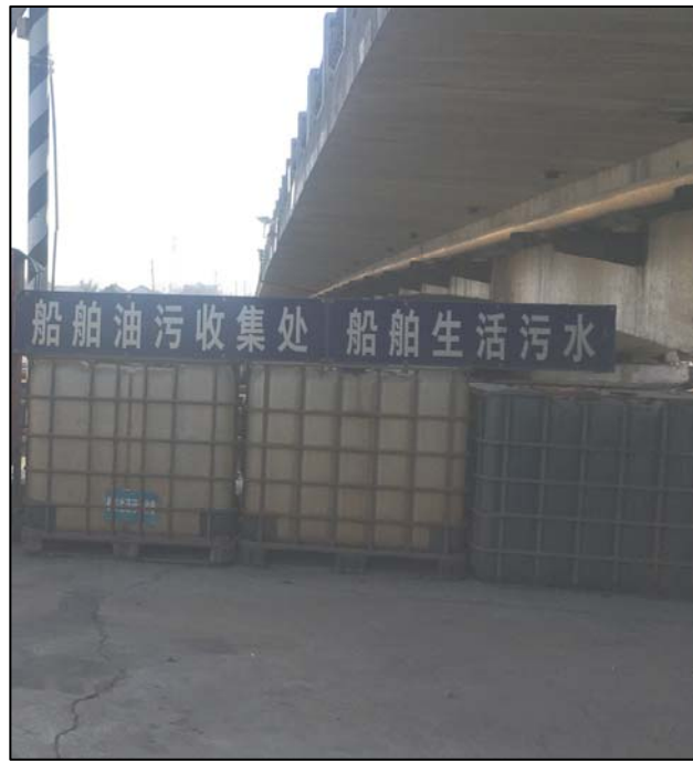
图 5.1-3 船舶生活污水和含油污水收集箱
