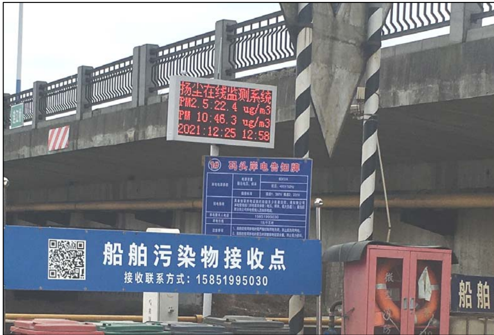
图 5.2-4 码头处已设置扬尘污染在线监测系统
