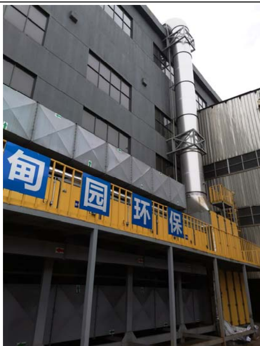
浇注废气“干式过滤—活性炭吸附—解吸催化燃烧”装置、FQ-17#排气筒
