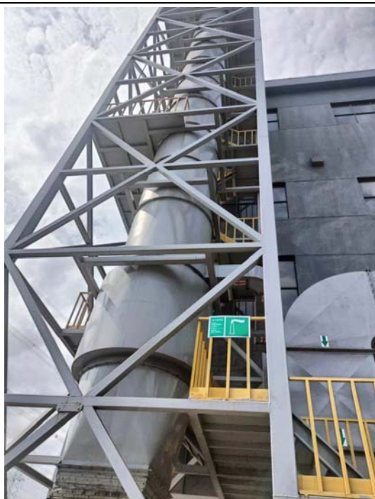
浇注废气“干式过滤—活性炭吸附—解吸催化燃烧”装置、FQ-17#排气筒
